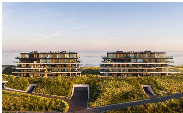
De Blanke Top, The Residence Cadzand, Bad - Nederland
