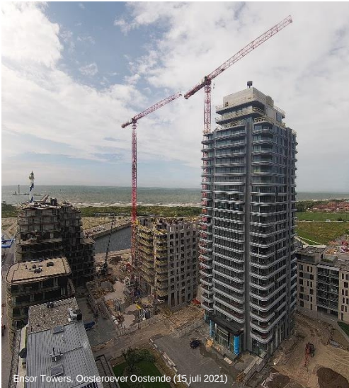
Ensor Towers, Oosteroever Oostende (15 juli 2021)
