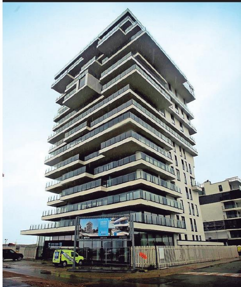
Appartementscomplex Waterfront op de Oosteroever.
