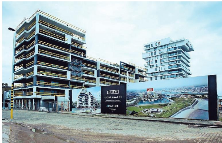
Het bouwproject van Versluys op Oosteroever. Foto Proot
